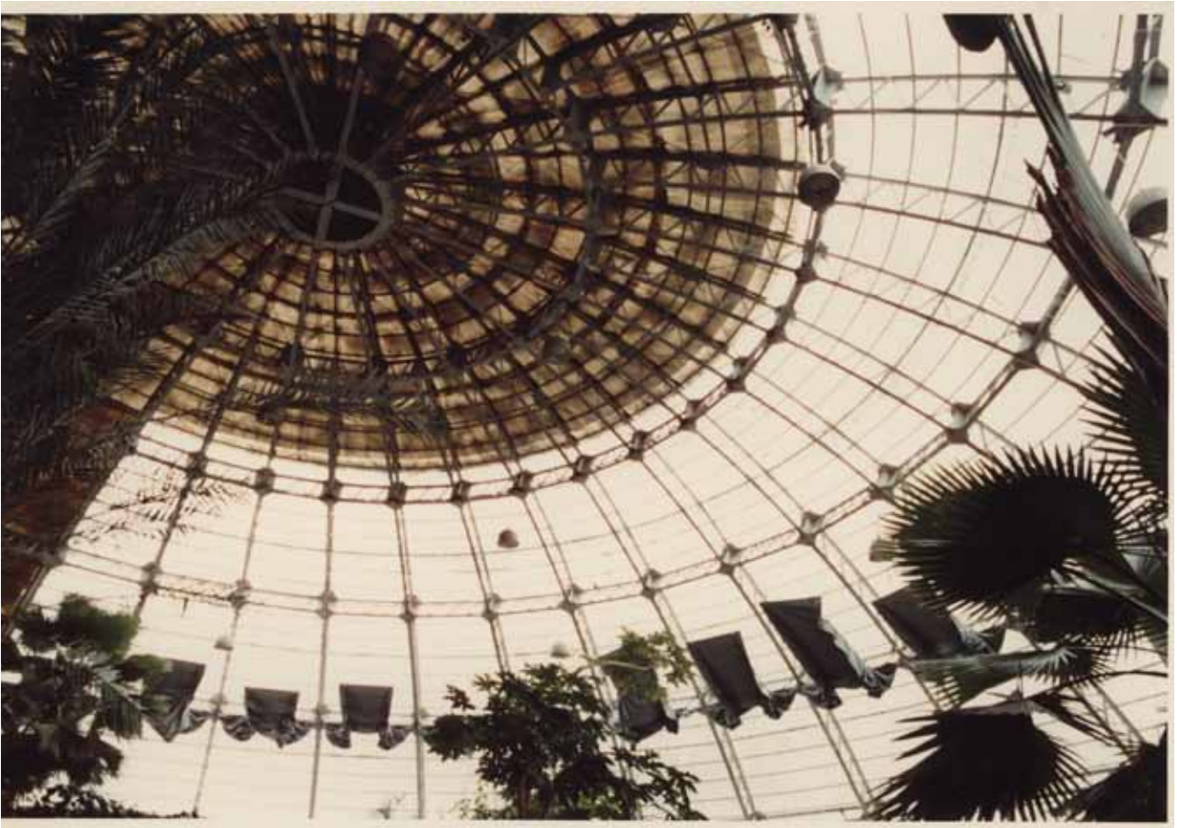
熱帯圏ドーム
